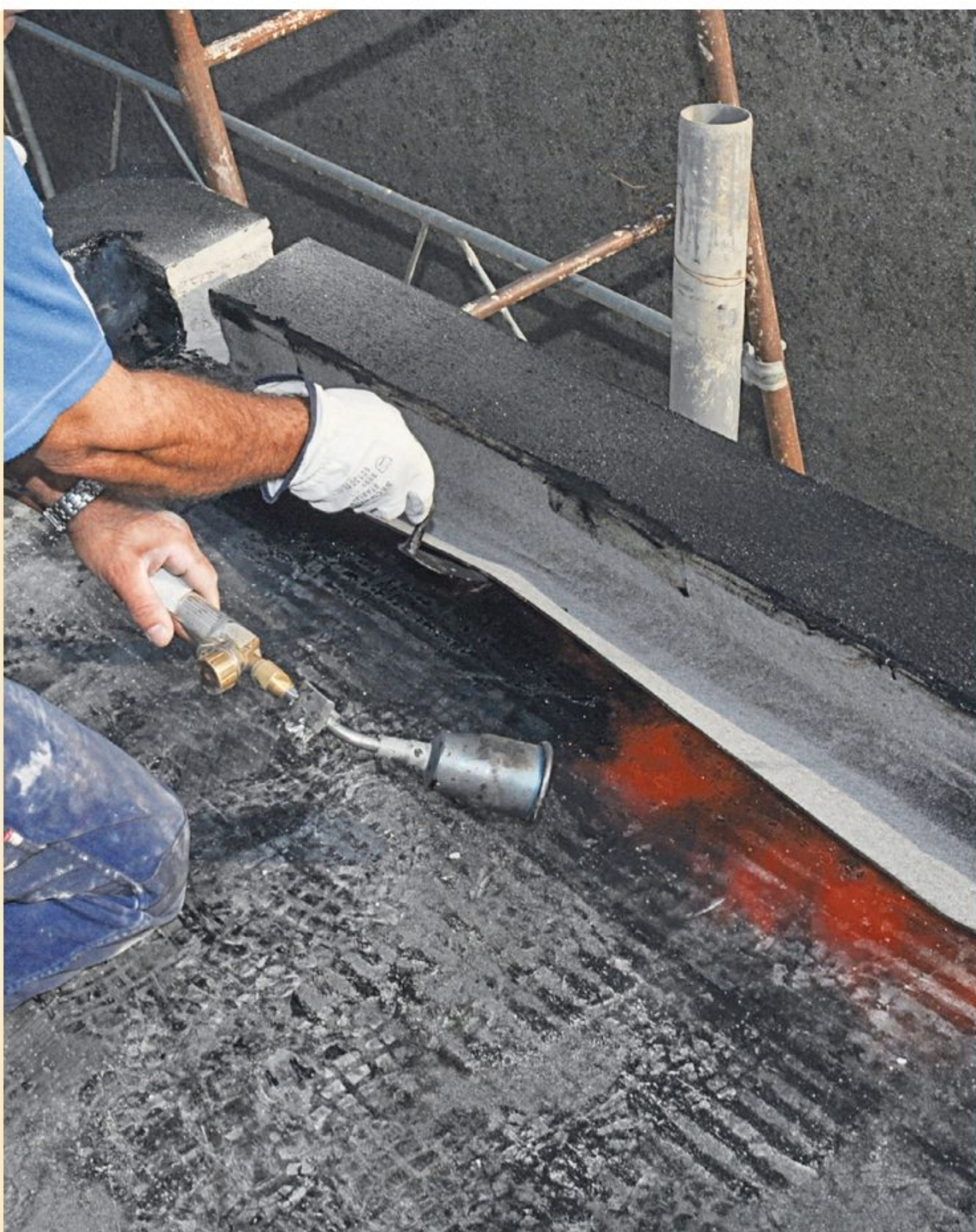
10 Comme précédemment, utilisez la lance courte du chalumeau pour chauffer l'envers de la moitié inférieure de la bande. Marouflez-la ensuite sur le toit.
