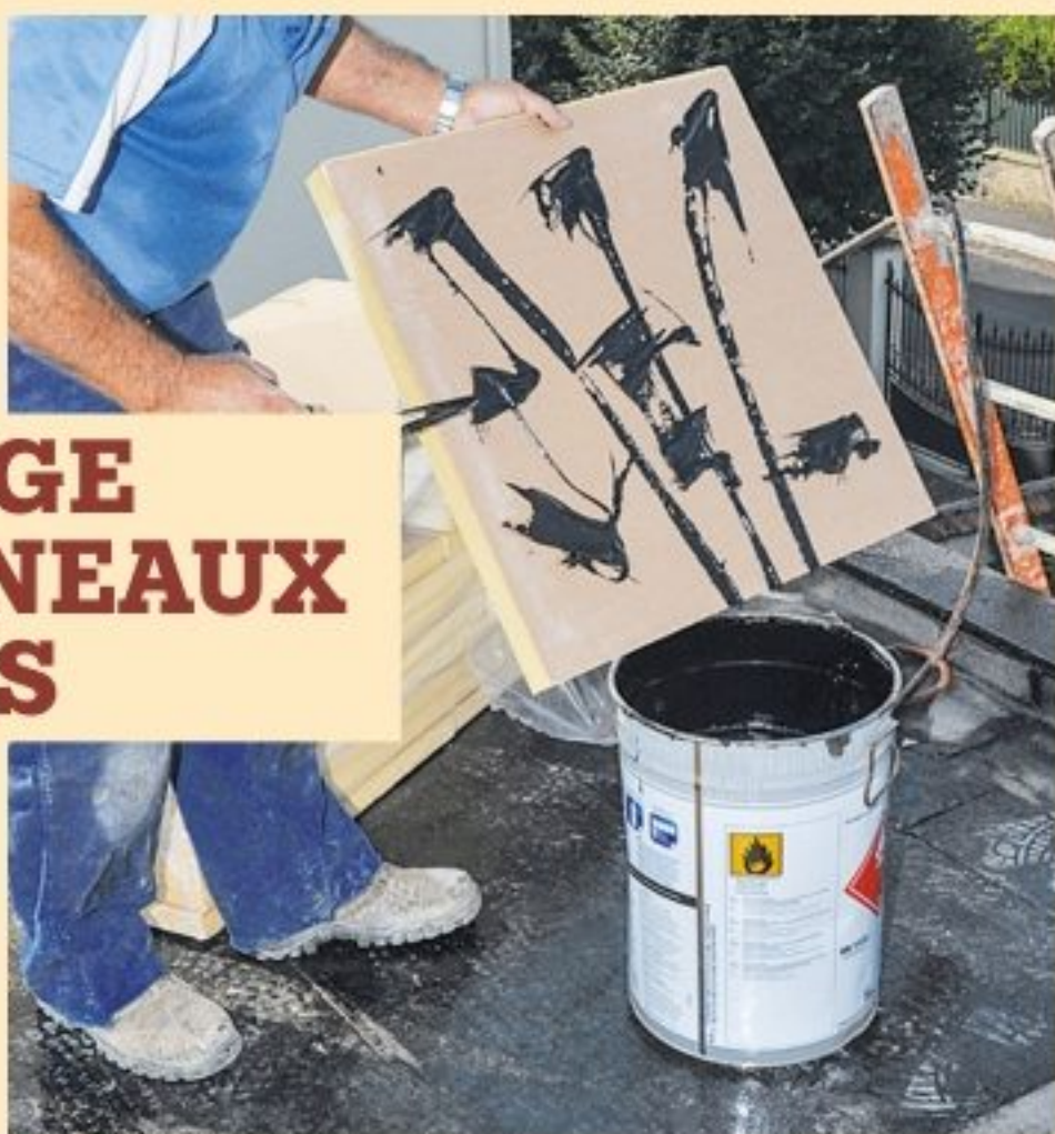
12 Encollez l'envers des panneaux avec une colle à froid à base de bitume. Déposez des plots rapprochés (neuf par panneau de 50 x 50 cm) à la truelle langue-de-chat.
