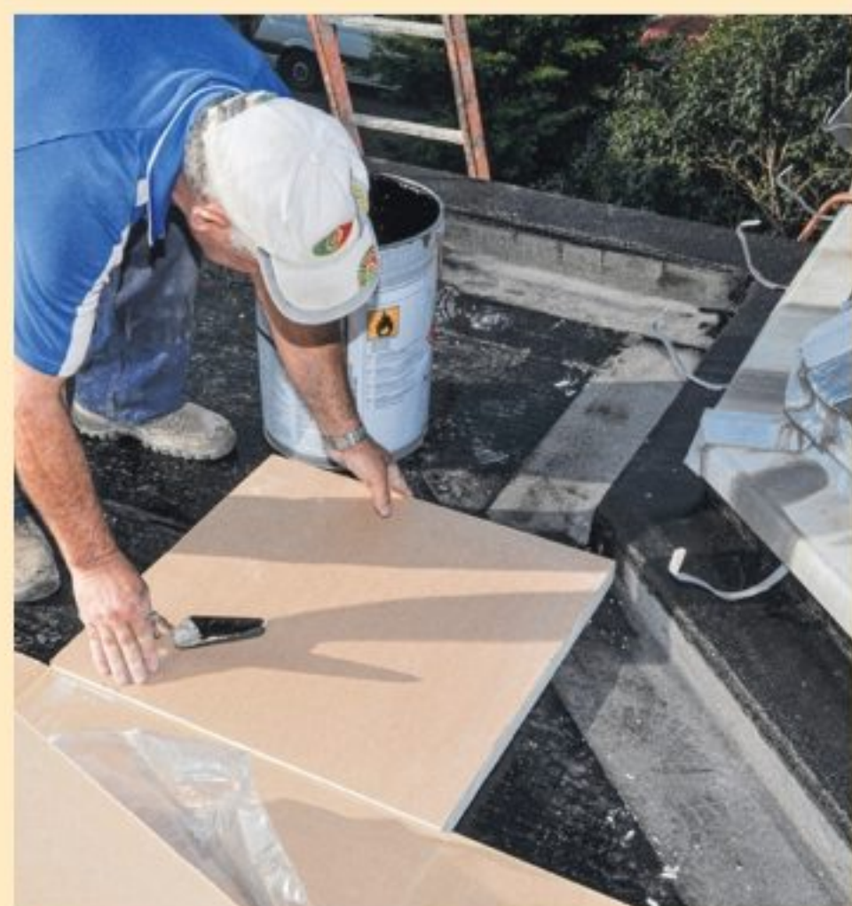
14 Poursuivez la pose des panneaux isolants, toujours à joint décalé, sans tenir compte des découpes particulières, dues ici à la forme de la toiture-terrasse.
