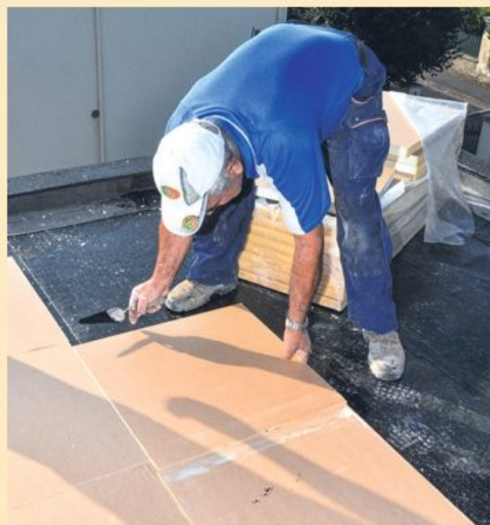
13 Posez une première rangée de panneaux isolants en polyuréthane contre un côté du toit. Débutez la deuxième rangée par une chute ou un demi-panneau afin de décaler les joints.
