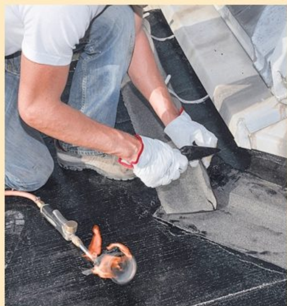
11 En présence de tracé particulier (de biais), veillez à ce que la bande d'étanchéité recouvre parfaitement les bandes posées de part et d'autre.
