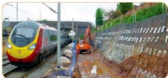
پایدار سازی شیب به روش میخ‌کوبی
