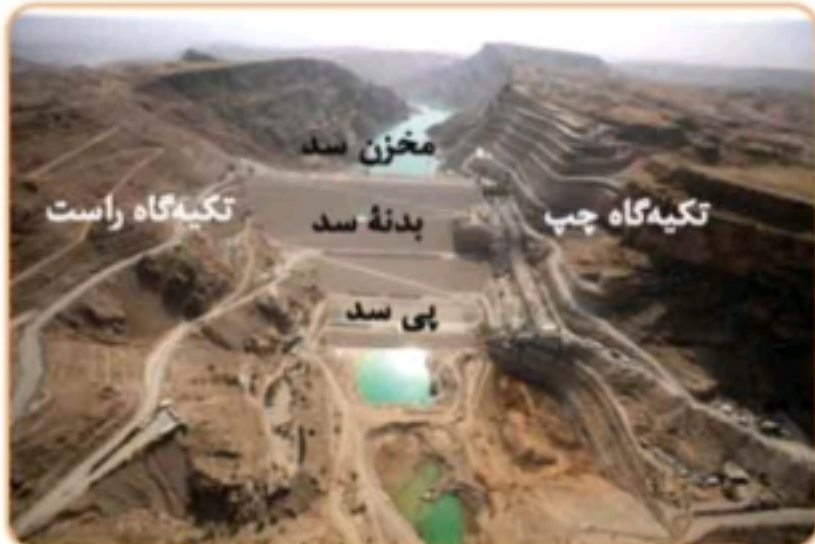
نمایی از بخش‌های مختلف یک سد
