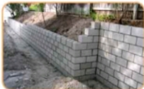
پایدار سازی شیب به روش دیوار حائل
