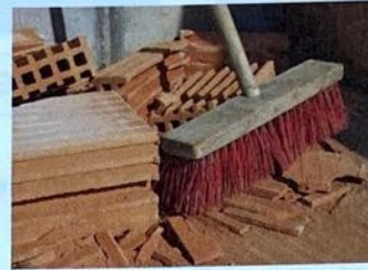
Mo, 15:00–15:30 Baustelle aufräumen
