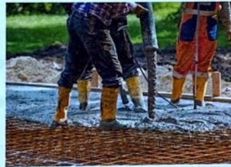
Di, 12:00–15:00 Fundament betonieren
