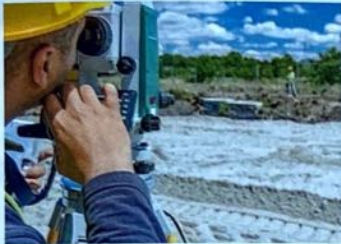
Mo, 7:00–12:00 Baustelle vermessen
