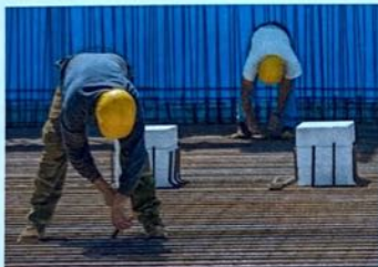
Di, 7:00–11:30 Betonieren vorbereiten
