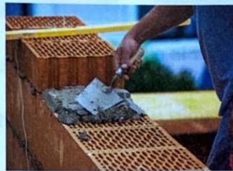
Mo, 12:30–15:00 Wand mauern
